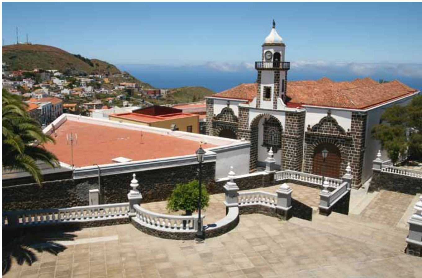
A Valverde, les habitants bénéficieront d'un réseau d'irrigation provenant de la centrale pour créer des potagers écologiques.
